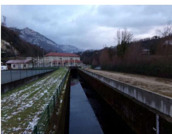
Photo 4: mur protégeant le canal de fuite EDF des débordements de La Vernaison (à droite sur la photo).
