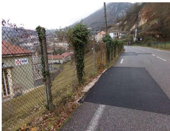
Photo 20: signes de glissement de terrain à l'amont de l'usine électrique d'EDF (RD518 et terrain déformés).
