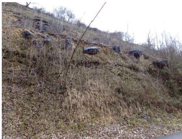
Photo 19: talus vertical à l'amont du chemin de Bernissart d'où peuvent se détacher des paquets de matériaux et des blocs.
