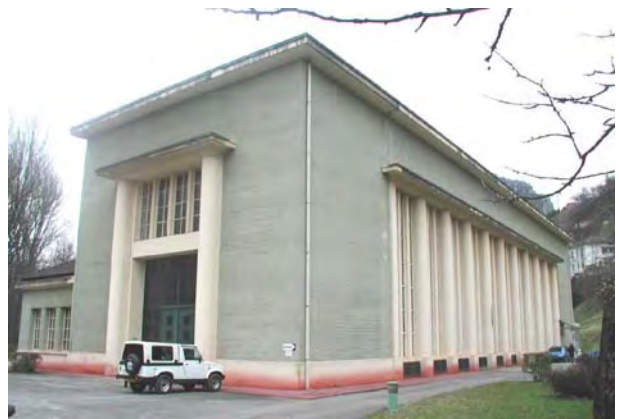
Figure 25 La centrale électrique
